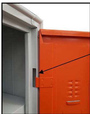
Cardine e perno di rotazione Interno
